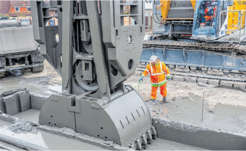
Die Geräte, die bei der Arbeit am Wesertunnel zum Einsatz kommen, sind mächtig. Aber das passt zur Größe der Aufgabe.
